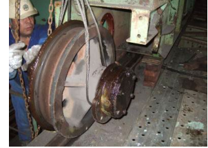
クレーン車輪取替作業
