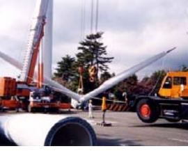
風力発電装置の建柱
