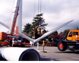
風力発電装置の建柱
