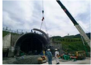
トンネル工事
