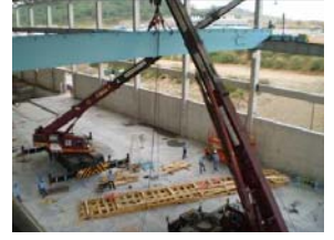
タイでのクレーン上架作業
