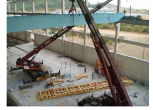
タイでのクレーン上架作業
